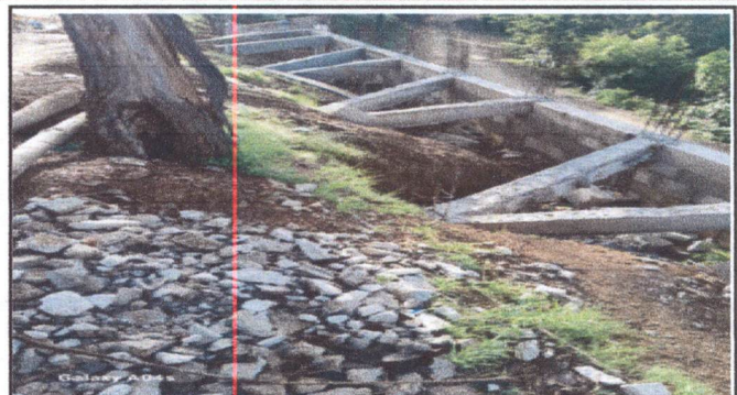
Foto 2: REPARACION DE MURO DE CONTENCIÓN
