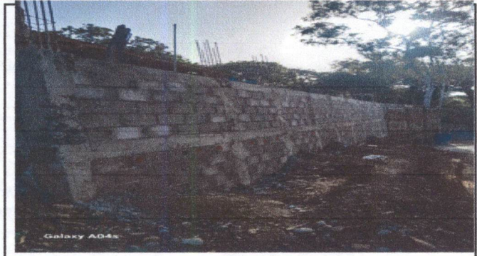
Foto1:REPARACION DE MURO DE CONTENCIÓN.
