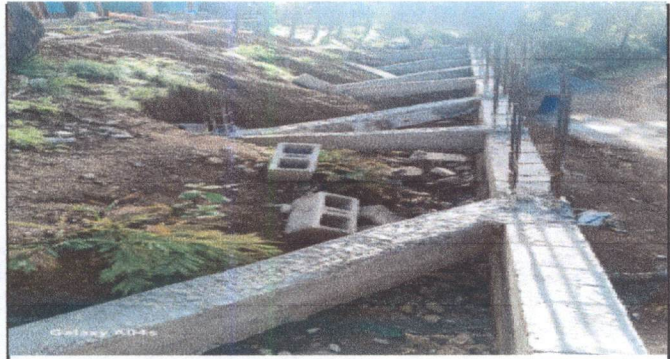
Foto 3: REPARACION DE MURO DE CONTENCIÓN
