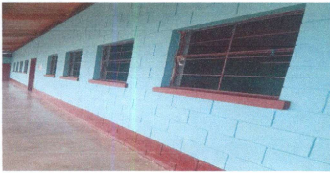
Foto 3: fabricacion y colocacion de balcones
