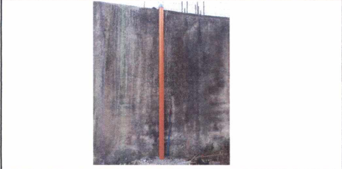
FOTO 7: SUSTITUCIÓN DE DRENAJE DE PILAS DE COCINA
