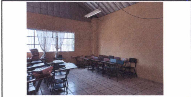
FOTO 2: APLICACIÓN DE PINTURA EN MUROS INTERIORES
