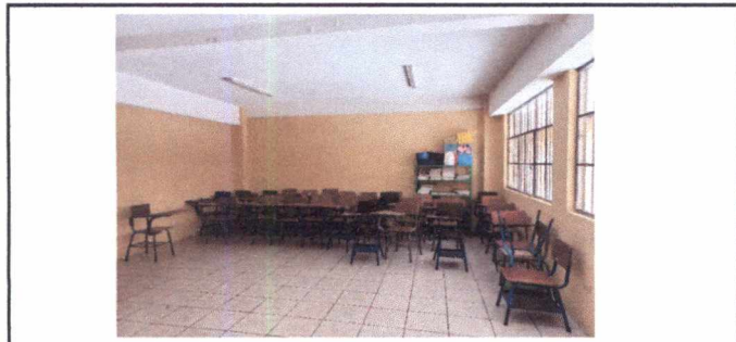
FOTO 3: APLICACIÓN DE PINTURA EN MUROS INTERIORES
