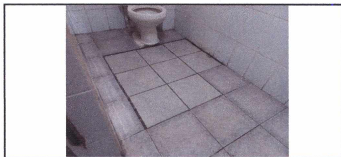
FOTO 6: SUSTITUCIÓN DE DRENAJE DE SERVICIOS SANITARIOS
