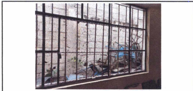
FOTO 4: INSTALACIÓN DE BALCONES REFORZADOS CON HIERRO
