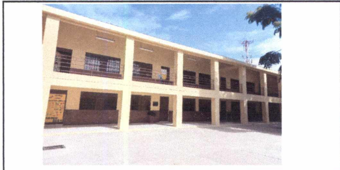
FOTO 1: APLICACIÓN DE PINTURA EN MUROS EXTERIORES
