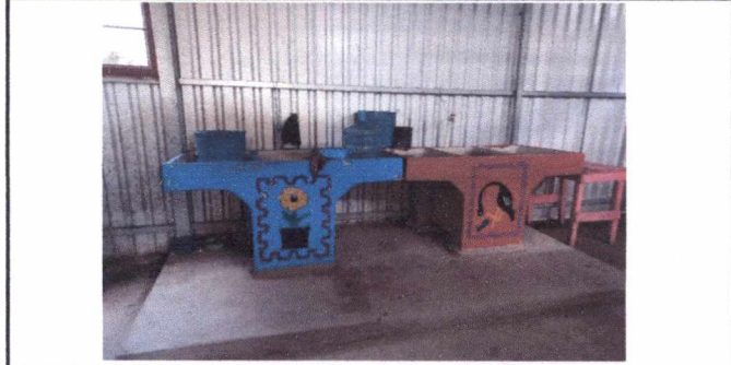
FOTO 8: SUMINISTRO E INSTALACIÓN DE PILAS (TRABAJO EXTRA)
