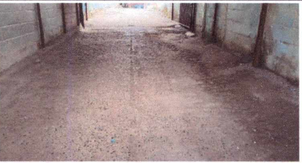
Foto 17: pavimentacion en la entrada principal del establecimiento. No 16
