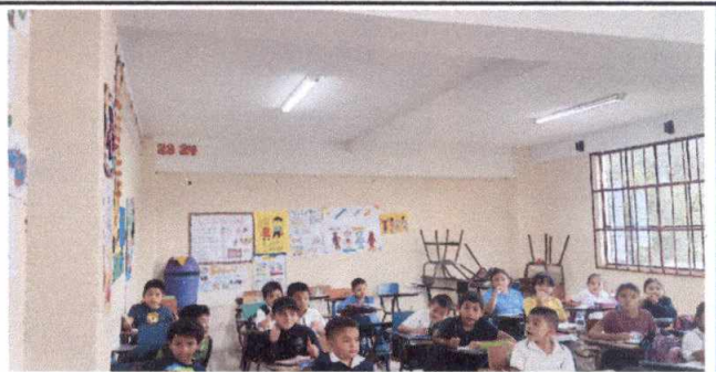
Foto 12: pintura en el interior de salon de clases, planta baja modulo de primaria. No 9
