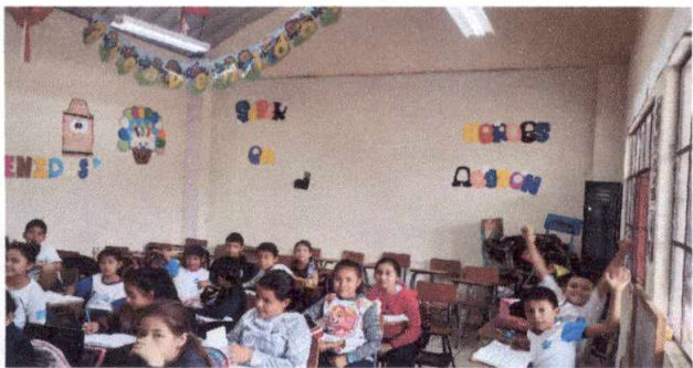
Foto 15: pintura en el interior de salon de clases, planta alta modulo de primaria. No. 9
