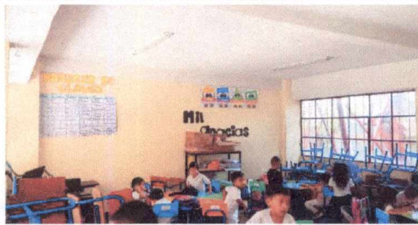
Foto 3: pintura en el interior del salon 1 de preprimaria. No.9
