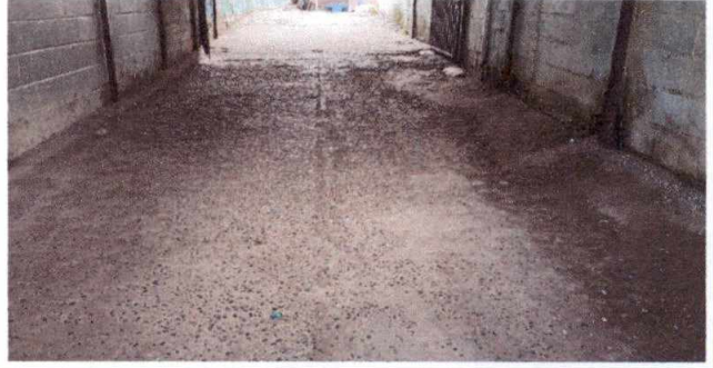
Foto 18: pavimentacion en la entrada principal del establecimiento. No 16
