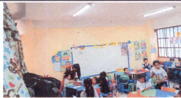
Foto 5: pintura en el interior del salon 3 de preprimaria. No 9
