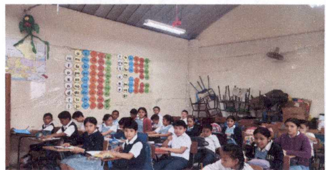
Foto 14: pintura en el interior de salon de clases, planta baja modulo de primaria. No. 9
