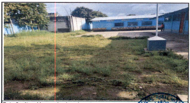
Foto 6: situación previa al pavimento.
