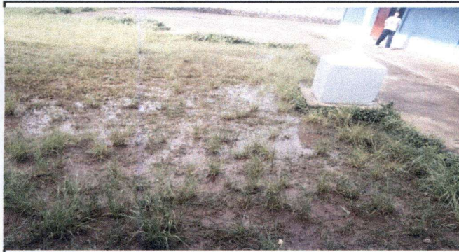
Foto 1; Situación previa al pavimento.
