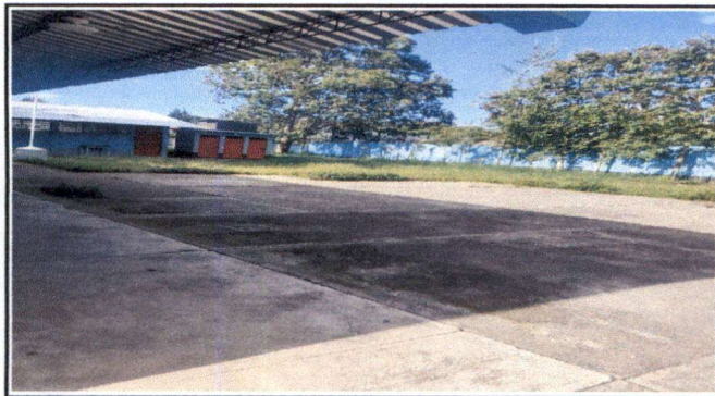
Foto 3: Situación actual del pavimento.
