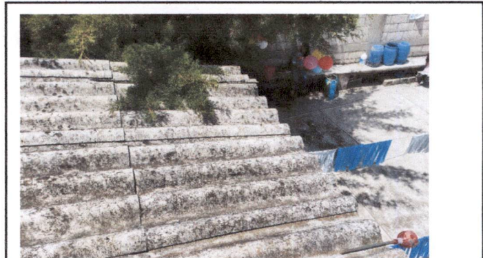
Fotografía 8: Se observa lamina de tipo fibra cemento.
