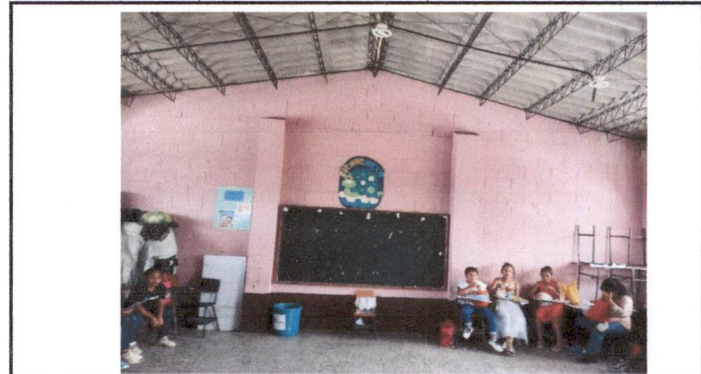
Fotografía 2: Se observa estructura portante de metal del modulo 1.
