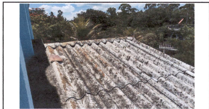
Fotografía 6: Imagen que muestra el techo de fibrocemento sobre el ambiente de cocina.
