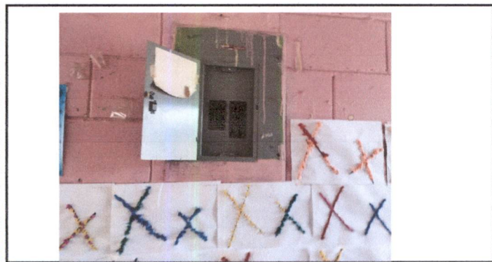
Fotografía 11: Se observa el tablero de distribución secundario que alimenta módulo principal
