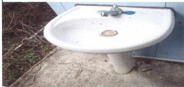
10.5 Sustitución de lavamanos
