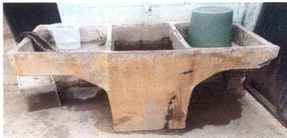
19.20 Instalacion de Pila de concreto (incluye conexión a drenaje)
