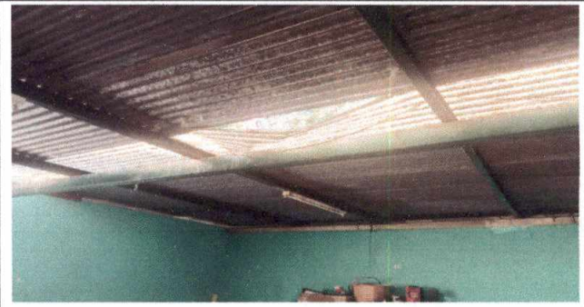
2.1 Mantenimiento a estructura de soporte de metal
