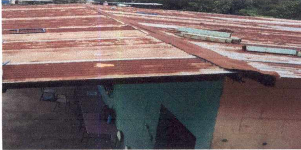
1.1 Sustitución de lámina, por lámina troquelada aluzinc calibre 26
