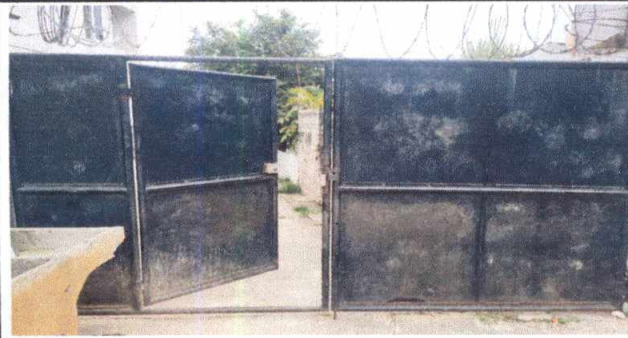
12.1 Mantenimiento a portones de metal
