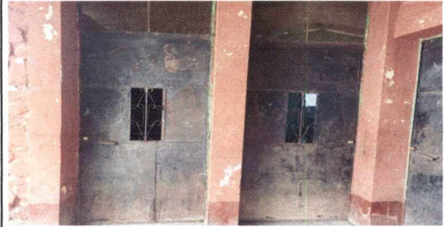
4.1 Mantenimiento a estructura (lijado, cambio de tubo , cepillado, sujeciones, aplicación de pintura)
