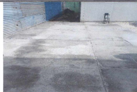
FOTO 6: FUNDICIÓN DE TORTA DE CONCRETO EN PATIO
