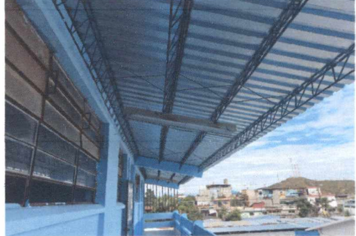
FOTO 2: SUSTITUCIÓN DE LÁMINA POR LÁMINA TROQUELADA Y MANTENIMIENTO A ESTRUCTURA DE SOPORTE DE METAL EN CORREDOR
