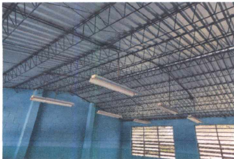
FOTO 3: SUSTITUCIÓN DE LÁMINA POR LÁMINA TROQUELADA Y MANTENIMIENTO A ESTRUCTURA DE SOPORTE DE METAL EN AULA
