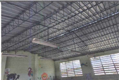
FOTO 5: SUSTITUCIÓN DE LÁMINA POR LÁMINA TROQUELADA Y MANTENIMIENTO A ESTRUCTURA DE SOPORTE DE METAL EN AULAS
