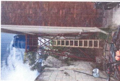
Foto 5: sustitución tinaco con torre y base de metal
