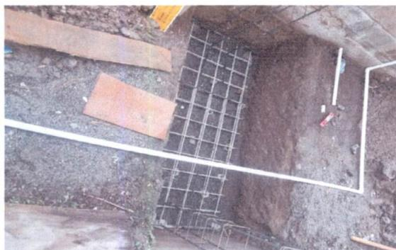
Foto 3: sustitución y colocación de base de metal para tinaco
