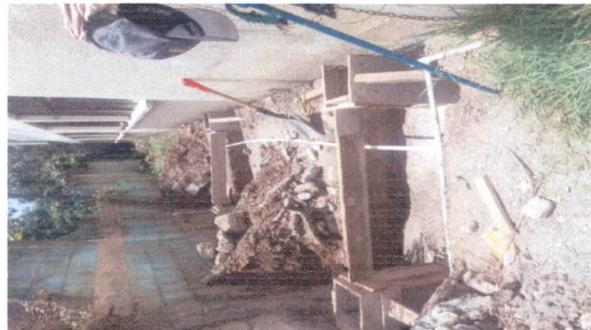
Foto 2: sustitución de tuberías para llenado de tinaco
