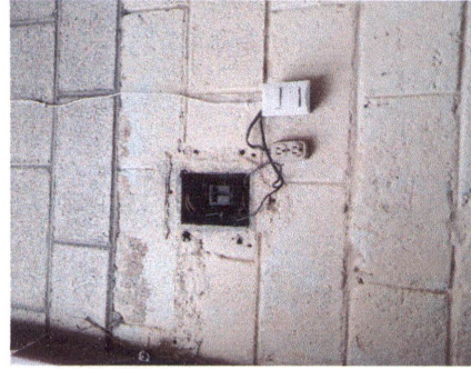
Foto 8: sustitución de tablero de flipones.
