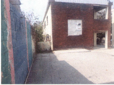
Foto 7: área en la que se instalará tinaco con base de estructura metálica
