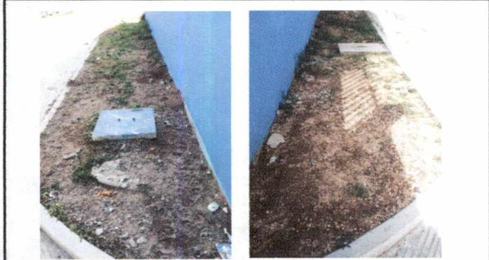
FOTO 1: BANQUETA EXTERIOR, ES NECESARIO COLOCAR TORTA DE CONCRETO
