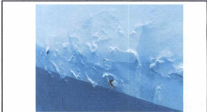
FOTO 4: MURO QUE PRESENTA DAÑOS POR HUMEDAD, ES NECESARIA LA REPARACIÓN DEL ACABADO E IMPERMEABILIZACIÓN
