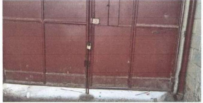
Foto 2: Mantenimiento a Porton de ingreso principal, (lijado, ajustado y pintado)
