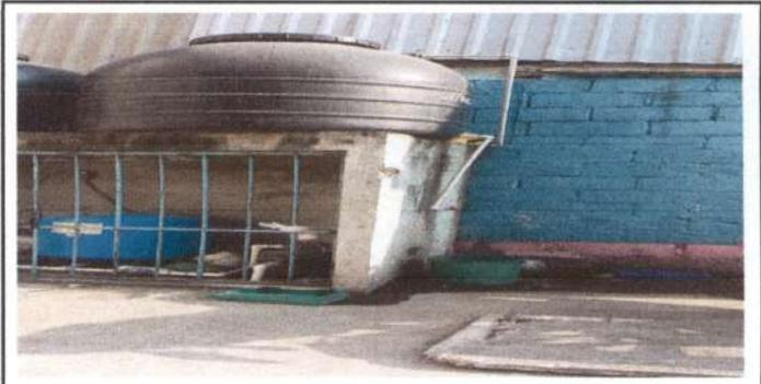
Foto 12: instalción de pila, con sus conexiones de agua potable y drenaje
