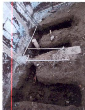
foto 4. Modificaciones del sistema Hidraulico y de drenaje para redacuacion de los nuevos sanitarios por instalar.
