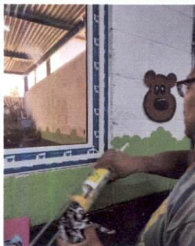
foto 5. Sustiticion de ventanas de metal, por ventanas pvc
