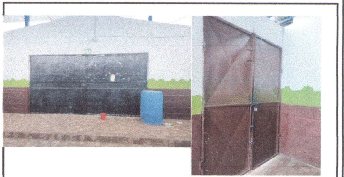
foto 4. Reparacion y mantenimiento de portones
