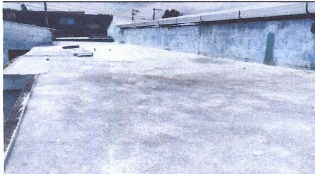
Foto 2: Reparación de Pañuelos, e impermeabilización de losa.
