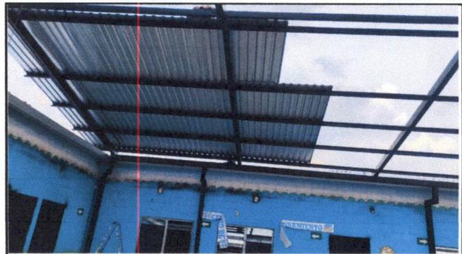
Foto 1.1: Mejoramiento de estructura portante por tijeras de costaneras de 2C mas lámina de Aluzinc calibre 26.
