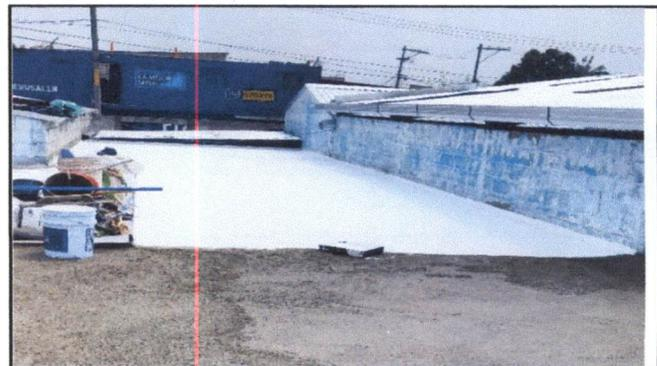
Foto 2.1: Reparación de Pañuelos, e impermeabilización de losa.
