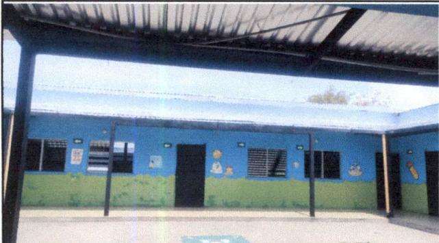
Foto 1: Mejoramiento de estructura portante con apoyos de concreto, con zapata, más pedestal de concreto, columna metálica tipo costanera 2C de 6" unidas con platina .
