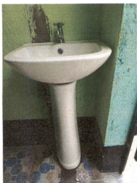
INSTALACIÓN DE LAVAMANOS
