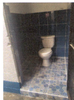
INSTALACION DE SANITARIO CON SUS ACCESORIOS
