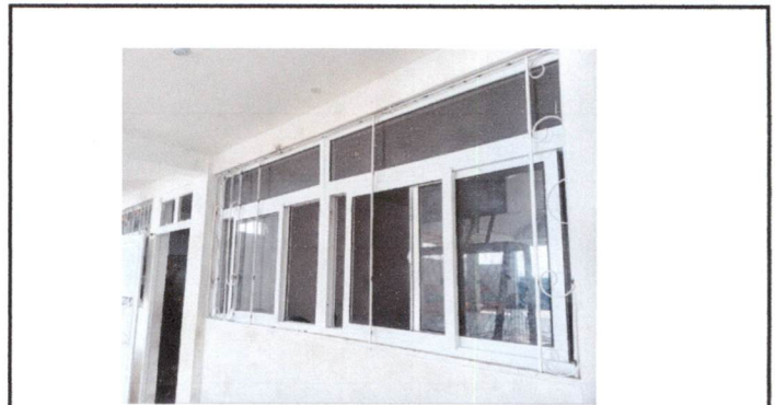
Mantenimiento de balcones
