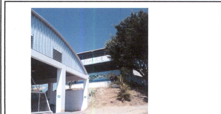
Pintura de muros exteriores
