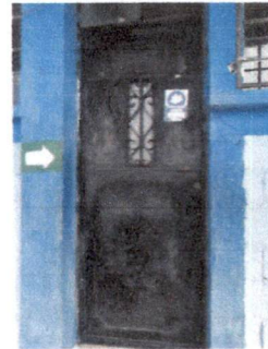
Mantenimiento de Estructura
