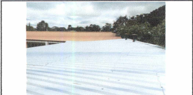
FOTO 1: SUSTITUCIÓN DE LÁMINA POR LÁMINA TROQUELADA CALIBRE 26
