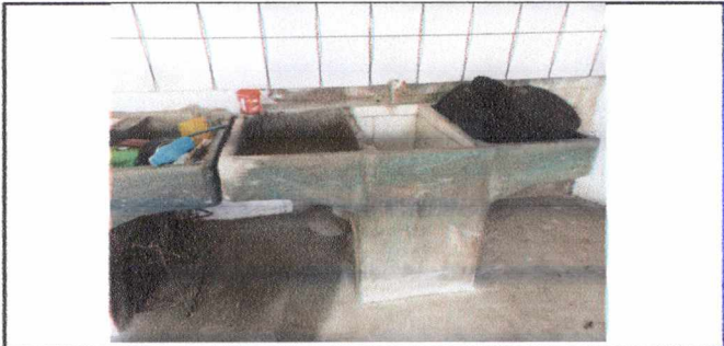
FOTO 10: REPARACIÓN DE PILAS EXISTENTES
