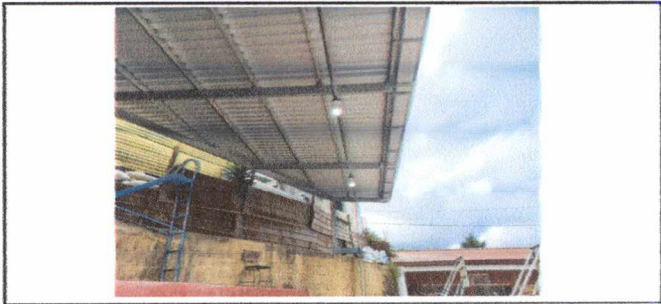
FOTO 12: (TRABAJO EXTRA) INSTALACIÓN DE LÁMPARAS
