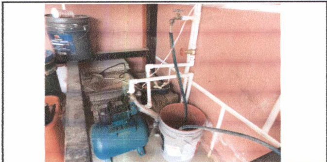
FOTO 7: INSTALACIÓN DE BOMBA DE 1/2 HP
