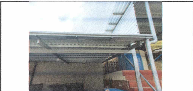
FOTO 4: INSTALACIÓN DE CANAL DE METAL CON PESCANTES
