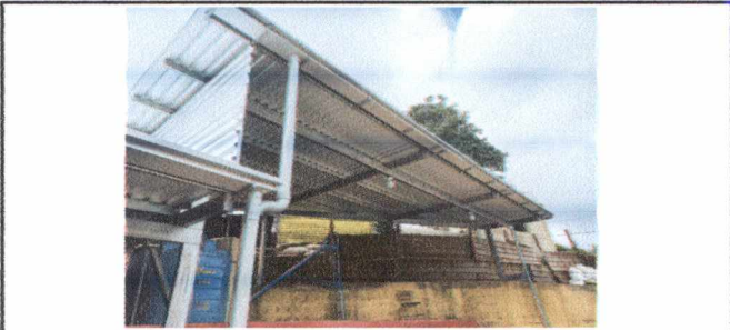
FOTO 6: INSTALACIÓN DE BAJADA DE AGUA PLUVIAL CON TUBO PVC DE 4"
