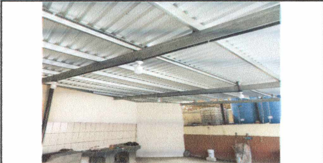
FOTO 2: SUSTITUCIÓN DE ESTRUCTURA DE SOPORTE DE METAL
