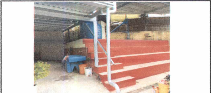
FOTO 5: INSTALACIÓN DE BAJADA DE AGUA PLUVIAL CON TUBO PVC DE 4"
