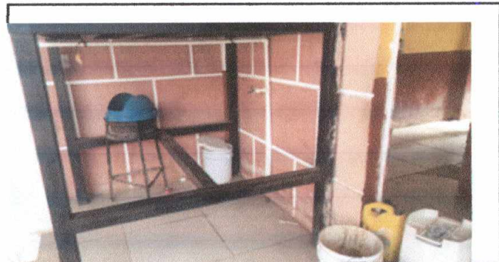
Foto 6: 18.7 Instalación de hidrobomba
