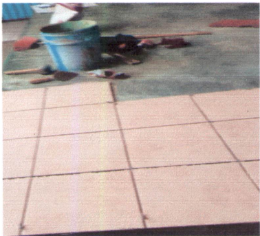
Foto 3: REGLÓN 6; PISO, SUSTITUCIÓN E INSTALACIÓN DE PISO CERÁMICO (1 AULA) EN PROCESO
