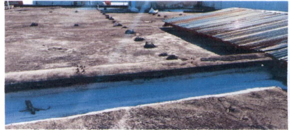
Foto 2: REGLÓN 3; PREPARACIÓN, LIMPIEZA, LAVADO Y APLICACIÓN DEL PRODUCTO IMPERMEABILIZACIÓN DE LOZA
