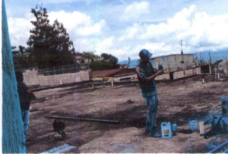
Foto 1: REGLÓN 3; PREPARACIÓN, LIMPIEZA, LAVADO Y APLICACIÓN DEL PRODUCTO IMPERMEABILIZACIÓN DE LOZA
