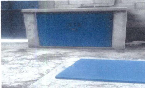
Foto 1 REPARACION Y MANTENIMIENTO DE CISTERNA
