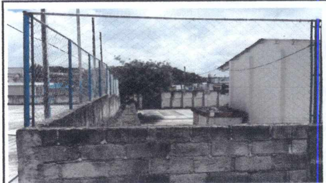
Foto 5: REPARACION DE TUBO HG Y MALLA GALVANIZADA
