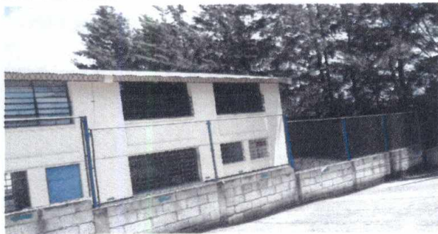
FOTO 3: MANTENIMIENTO A ESTRUCTURA DE METAL DE VENTANA
