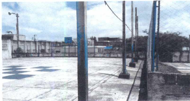
Foto 5: REPARACION DE TUBO HG Y MALLA GALVANIZADA
