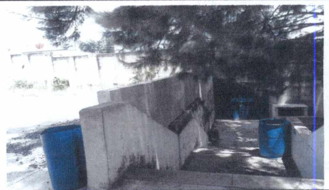
Foto 3: REPARACION DE MURO PERIMETRAL DE BLOCK
