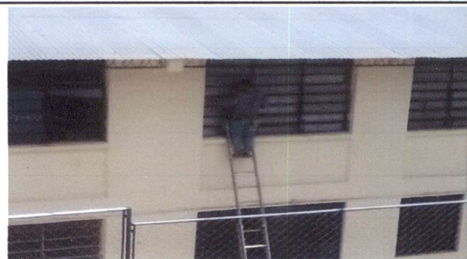
Foto 2: Mantenimiento a estructura de metal de ventana
