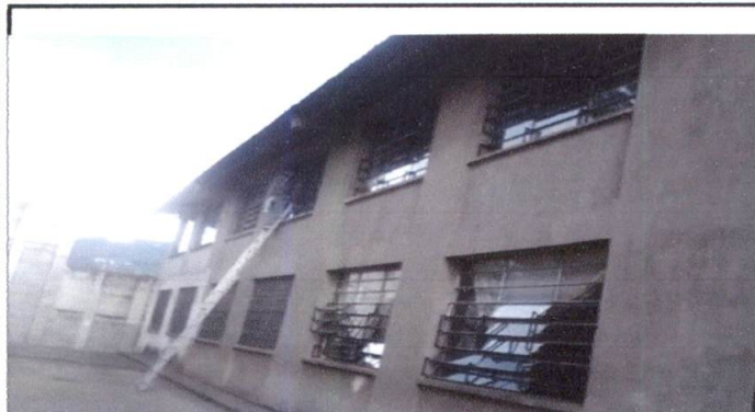
Foto 1: Mantenimiento a estructura de metal de ventana
