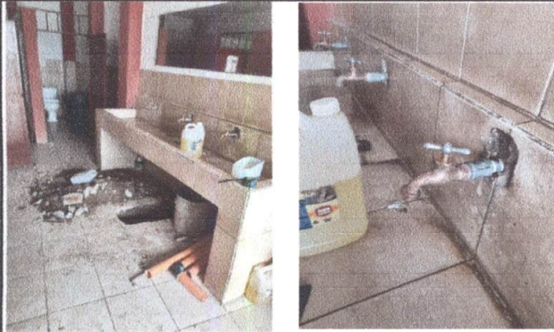
Foto 1: DESTAPE DE DRENAJE, CAMBIO DE CHORROS, TERMINADO.
