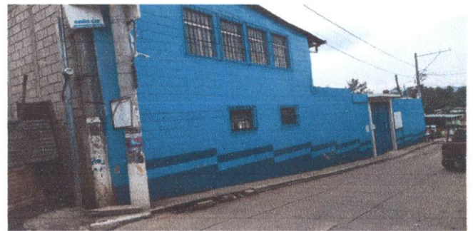
Foto 4: PINTURA EXTERIOR EN PROCESO.
