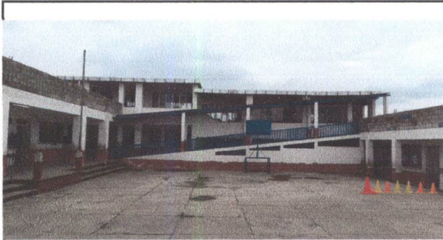
Foto 3: PINTURA DE MUROS EXTERIOR E INTERIOR, EN PROCESO.
