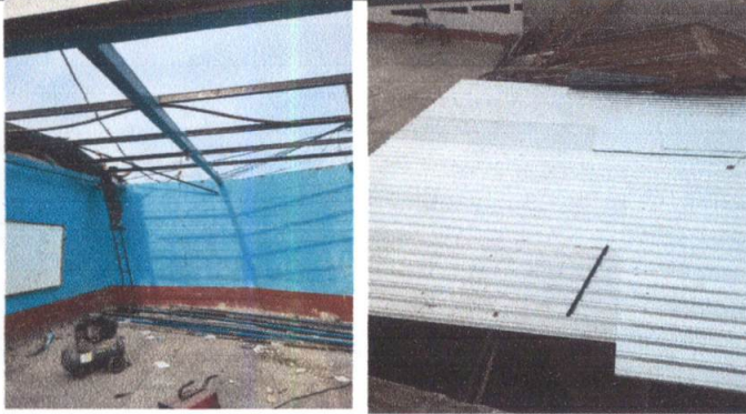
Foto1: CUBIERTA DE LAMINA TROQUELADA Y SUSTITUCION DE METAL POR METAL. TERMINADO
