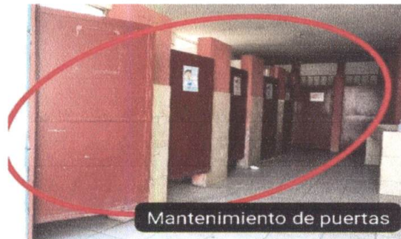
Foto 5: MANTENIMIENTO DE PUERTAS. TERMINADO.
