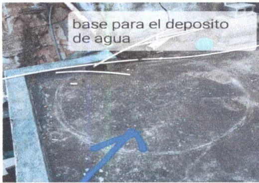
Foto 3: BASE PARA COLOCAR EL DEPOSITO DE AGUA, TERMINADO.
