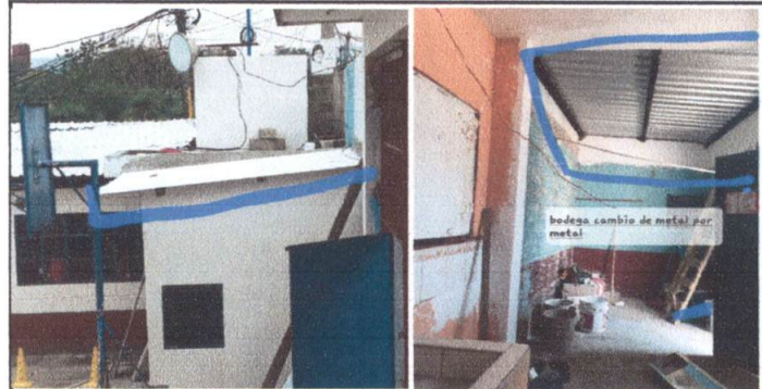
Foto 6: CABIO DE LAMINA TROQUELADA Y CAMBIO DE METAL POR METAL. TERMINADO.
