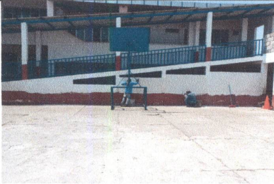
Foto 3: REPELLO DE RAMPA TERMINADO.
