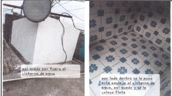
Foto 4: MANTENIMIENTO DE CISTERNA DE AGUA FLUVIAL, TERMINADO.
