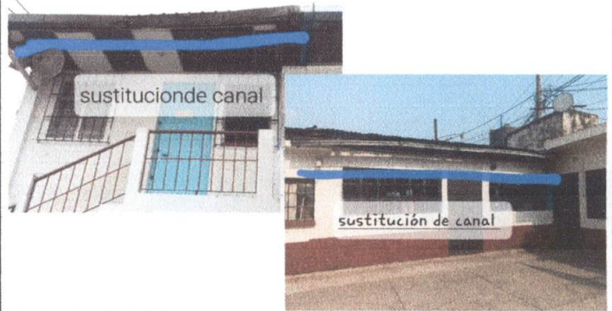
Foto 4: CAMBIO DE CANALES EN PROCESO
