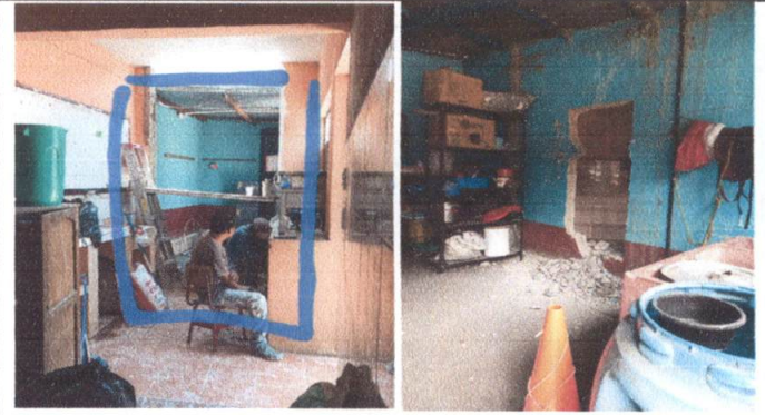
Foto 2: MEJORAMIENTO DE PARED, APERTURAS DE VANO DE COCINA A BODEGA . TERMINADO. FALTA INSTALACION DE PUERTA ESTA EN PROCESO.
