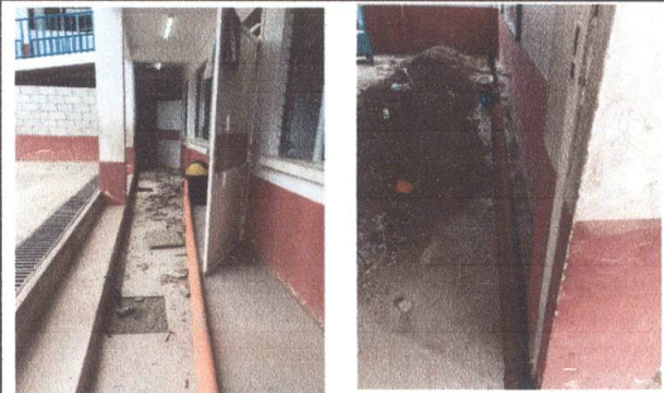
Foto 6: remozamiento finalizado, ya no hay inundación.
