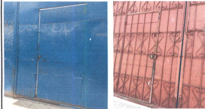
Foto1: remozamiento del portón en proceso.
