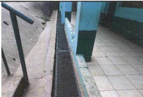
FOTO 5: MANTENIMIENTO A TAPADERAS DE METAL DE DRENAJE (REJILLAS)
