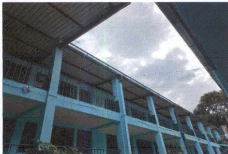
FOTO 3: SUSTITUCIÓN DE CANAL DE METAL
