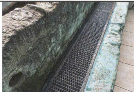
FOTO 6: MANTENIMIENTO A TAPADERAS DE METAL DE DRENAJE (REJILLAS)
