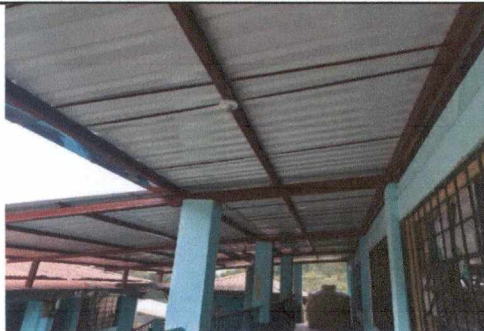
FOTO 4: SUSTITUCIÓN DE LÁMINA POR LÁMINA TROQUELADA CALIBRE 26
