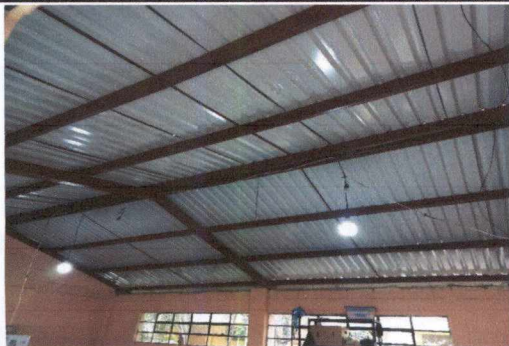
FOTO 1: SUSTITUCIÓN DE LÁMINA POR LÁMINA TROQUELADA CALIBRE 26
