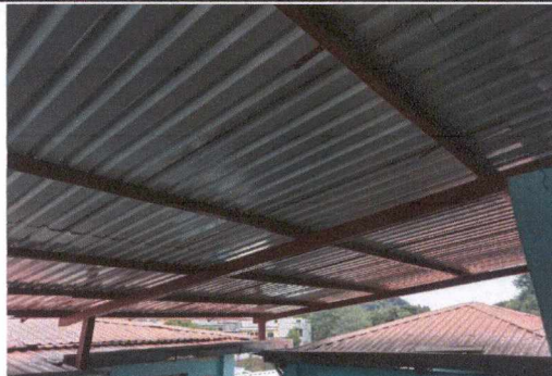
FOTO 2: MANTENIMIENTO A ESTRUCTURA DE SOPORTE DE METAL
