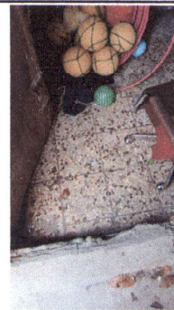
Foto 4: 6.9 Mantenimiento de piso de granito (pulido y lustrado) 11 mts.
