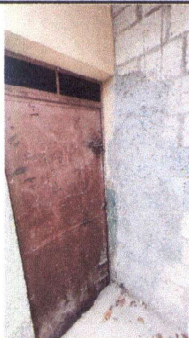
Foto 5: 4.3 Sustitución de puerta de metal de 2.50 mts x 1,00 mts chapa yale
