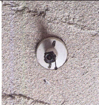
Foto 3: 19.12 Instalación de unidades de luz 30 mts de alambre 1 flaponera 2 tomacorriente 1 Swift.
