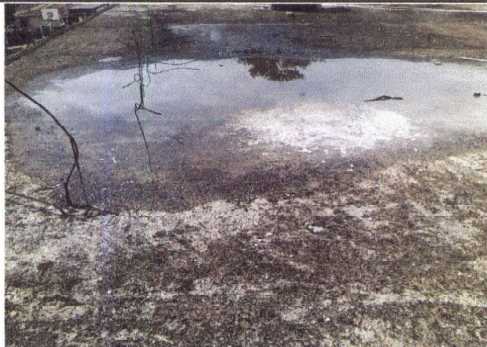
Foto 3: Reparación de bordillo tope en todo el contorno de la terraza 181,30 mts x20cms de alto x 15 cms de ancho, Nivelar 327 mts mesclon Y Hacer tope de agua de 16,80 mts.
