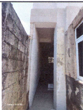
Foto 3: 19.6 Fabricación e instalación de 2 puertas de reja con chapas yale. 15.1 Reparación de 1x1 de block con medidas de 1.05 mts x 2.80 mts de alto.
