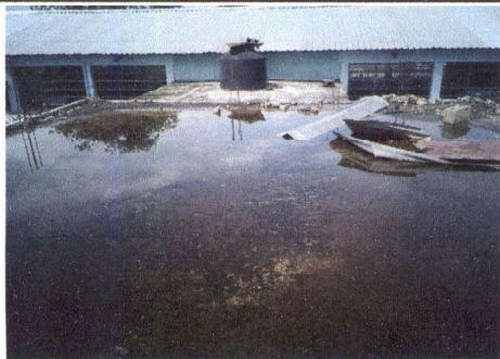
Foto 5: 3.1 Impermeabilizar 610 mts cuadrados de terraza.
