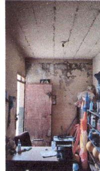
Foto 8: 21.1 Repello de pared aula 2,50 mts x 5,00 21.2 Cernido de pared aula 2,50 mts x 5,00 21.3 Alisado de pared aula 2,50 mts x 5,00
