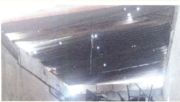
Foto1: 19.8 Instalación de lámina troquelada aluzinc techado 2.30 mts x 5.50 mts 19.7 Instalación de estructura portante de metal 15.1 Reparación de muro perimetral de block.
