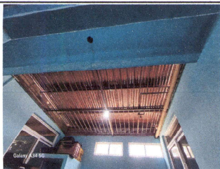
Foto1: 1.1 Sustitución de 6 laminas troqueladas atornilladas. 4.1 Mantenimiento de reja protectora medida del techo 4 mts x 4 mts total 16 mts más lijado de reja pintado y asergeria 16 mts 21.2 Cernido de block perimetral 6,40 mts 22.1 Reparación de muro perimetro.
