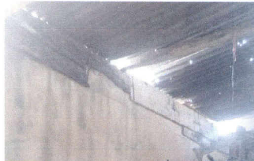
Foto 2: 19.8 Instalación de lámina troquelada aluzinc techado 3.70 mts x 5.00 mts 19.7 Instalación de estructura portante de metal 15.1 Reparación de muro perimetral de block.
