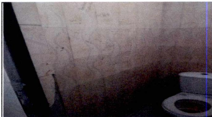
Foto 4. cambio de piso sanitario y demolición de azulejo en servicio sanitario de niña.
