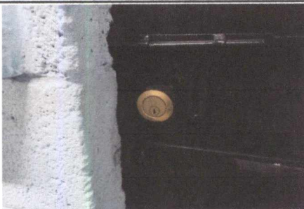
FOTO 11: SUSTITUCIÓN DE CHAPAS EN PUERTAS
