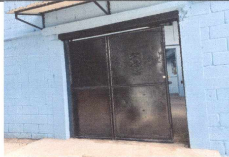
FOTO 4: MANTENIMIENTO DE PORTÓN DE METAL DE INGRESO
