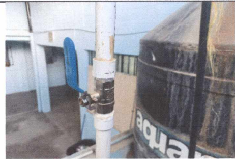
FOTO 10: SUSTITUCIÓN DE LLAVES EN TINACO
