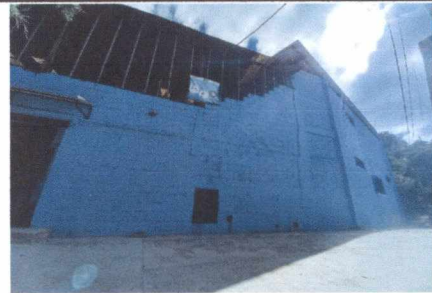
FOTO 12: APLICACIÓN DE PINTURA EN MUROS EXTERIORES
