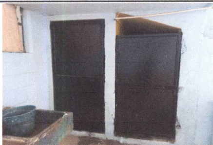
FOTO 5: SUSTITUCIÓN DE PUERTAS DE METAL EN SANITARIOS
