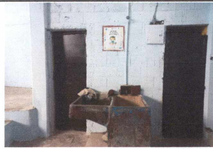
FOTO 6: SUSTITUCIÓN DE PUERTAS DE METAL EN SANITARIOS
