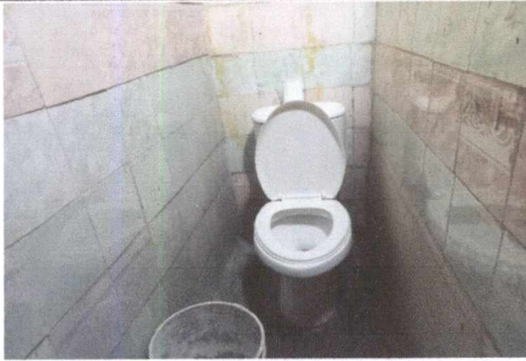
FOTO 7: SUSTITUCIÓN DE INODOROS
