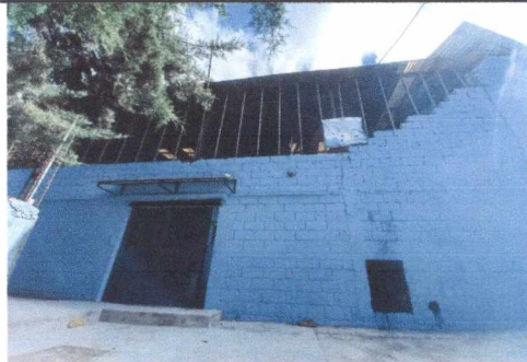
FOTO 2: APLICACIÓN DE PINTURA EN MUROS EXTERIORES
