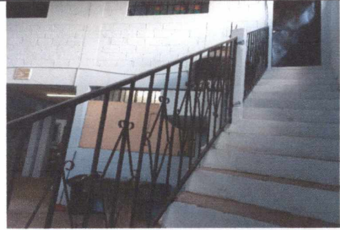
FOTO 8: MANTENIMIENTO A BARANDA DE METAL EN GRADAS
