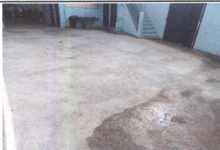
FOTO 3: SUSTITUCIÓN DE PLANCHAS DE CONCRETO EN PATIO
