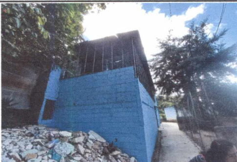
FOTO 1: APLICACIÓN DE PINTURA EN MUROS EXTERIORES
