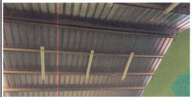
Foto 2: sustitución de lámparas tipo LED en aulas ya que las que están no funcionan
