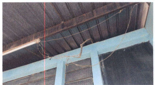
Foto 4: sustitución de lámparas tipo LED en corredores
