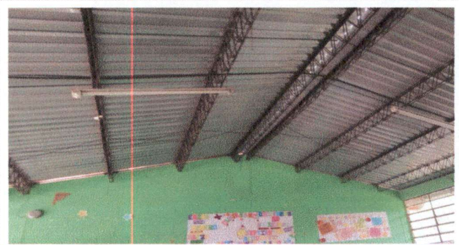
Foto 6: sustitución de timbres y cableado
