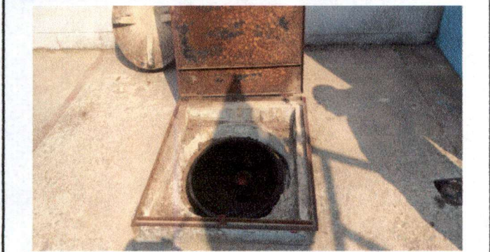
Foto 7: Se realizará la reparación de tapadera de fosa séptica y limpieza de la misma
