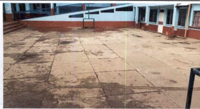
Foto 3: Reparación de piso de concreto en patio central, para evitar que se siga empozando el agua.
