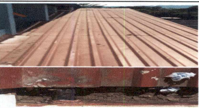
Foto 5: Reparación y limpieza de canal por filtraciones en el primer nivel
