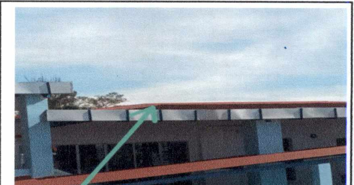
Foto 4: Sustitución de tornillería por filtraciones en lamina y capote en el segundo nivel.
