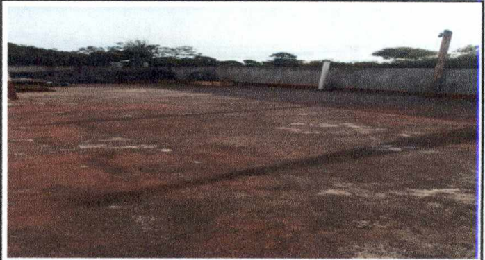
Foto 2: Reparación de grietas en techo de losa por filtraciones Segunda parte de la terraza.
