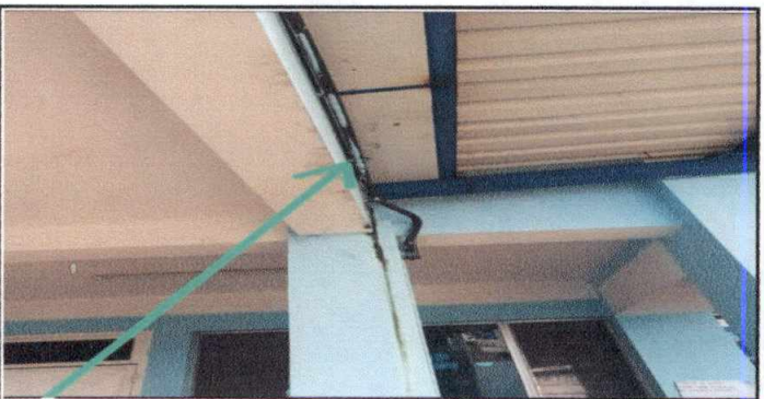
Foto 6: Reparación y limpieza de canal por filtraciones en primer nivel
