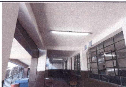
FOTO 6: SUSTITUCIÓN DE LÁMPARAS TIPO LED
