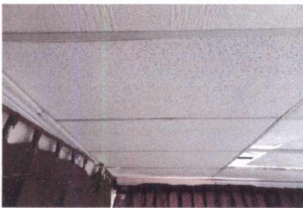
FOTO 3: SUSTITUCIÓN DE PLANCHAS DE CIELO FALSO
