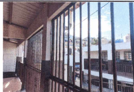
FOTO 12: INSTALACIÓN DE BALCONES DE METAL
