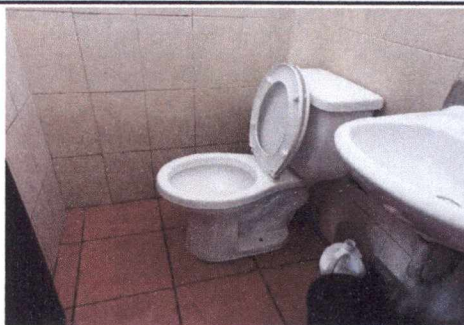
FOTO 14: SUSTITUCIÓN DE INODORO
