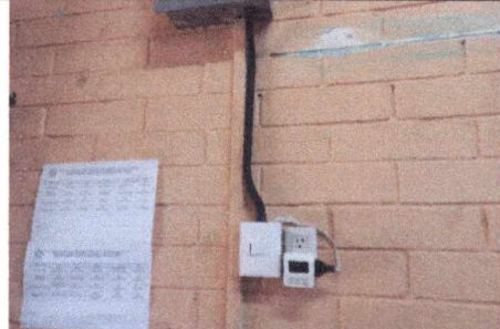
FOTO 4: REPARACIÓN DE TIMBRE EXISTENTE
