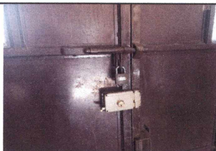
FOTO 16: SUSTITUCIÓN DE CHAPA EN PORTÓN DE INGRESO
