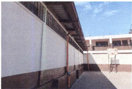
FOTO 9: INSTALACIÓN DE BAJADAS DE AGUA PLUVIAL
