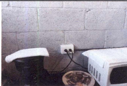
FOTO 11: SUSTITUCIÓN DE TOMACORRIENTES DOBLES
