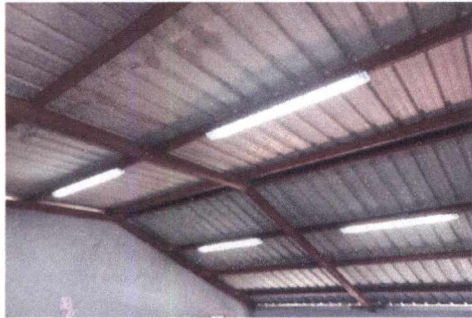
FOTO 7: SUSTITUCIÓN DE LÁMPARAS TIPO LED
