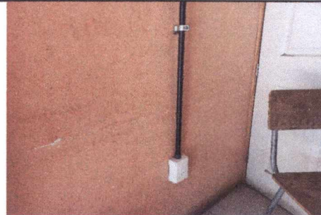
FOTO 10: SUSTITUCIÓN DE TOMACORRIENTES DOBLES
