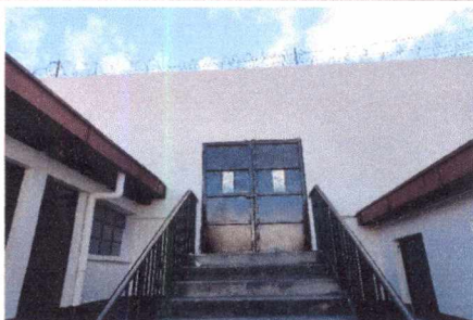
FOTO 15: SUSTITUCIÓN DE PORTÓN DE METAL DE DOS HOJAS
