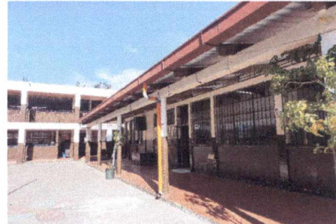
FOTO 8: INSTALACIÓN DE BAJADA DE AGUA PLUVIAL
