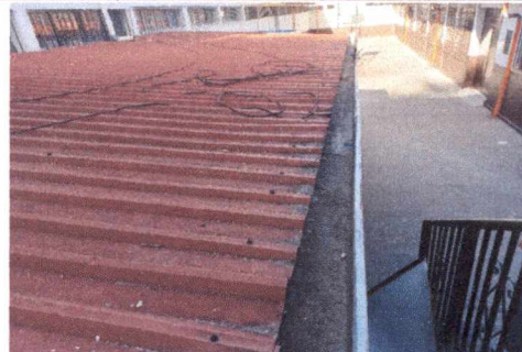
FOTO 2: LIMPIEZA DE CANALES
