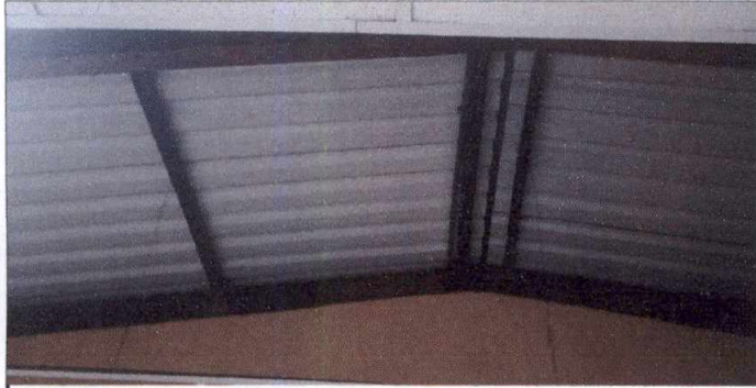
Foto1: 1.3 SUSTITUCIÓN DE ELEMENTOS DE FIJACIÓN EN CUBIERTA DE LÁMINA PARA REPARACIÓN DE FILTRACIONES, INCLUYE APLICACIÓN DE SIKA EN TORNILLOS EN SALON DE USOS MULTIPLES
