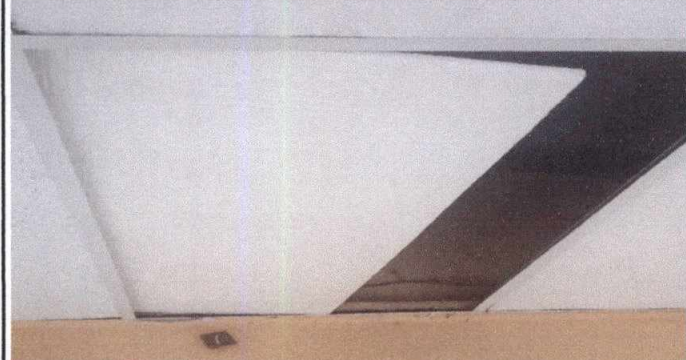
FOTO 15: 19.23 SUSTITUCIÓN DE PLANCHAS DE CIELO FALSO 2 PIES X 4 PIES
