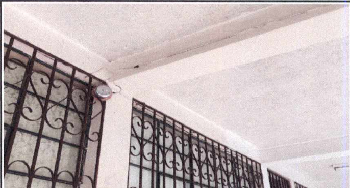
FOTO 14: 17.14 SUMINISTRO E INSTALACIÓN DE TIMBRE NUEVO Y REPARACIÓN DE TIMBRE EXISTENTE (INCLUYE ENTUBADO Y CABLEADO)
