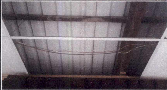
FOTO 13: 17.13 Suministro e instalación entubado y cableado de sonido e iluminación de salon de eventos (incluye tubería para sonido) que están interperie.
