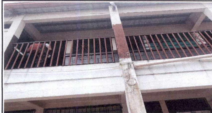
Foto 3: 5.6 SUMINISTRO E INSTALACION DE BALCONES CON MEDIDAS DE 1.21 mt x 2.48mt. Y 1.21.mt x 1.30mt.
