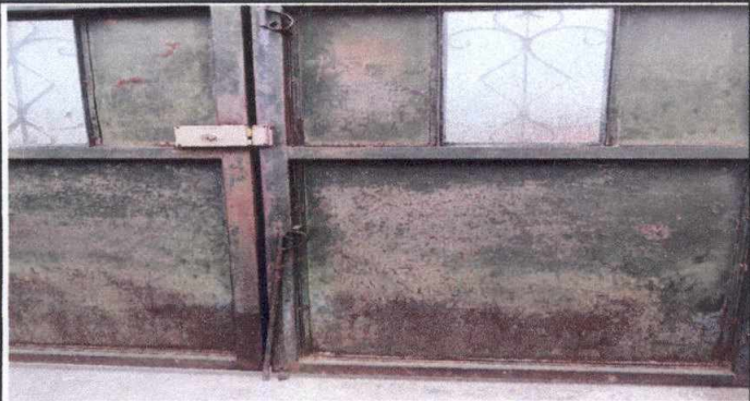
FOTO 7: 12.1 SUMINSITRO E INSTALACION DE PORTON DE METAL DE DOS HOJAS
