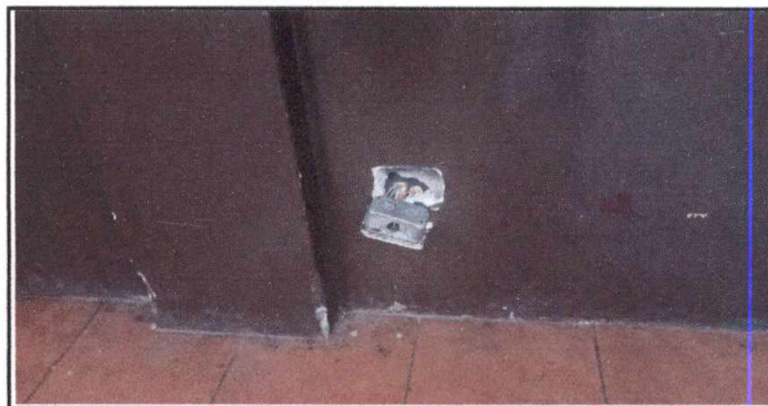
FOTO 12: 17.8 SUSTITUCIÓN DE TOMACORRIENTES DOBLES
