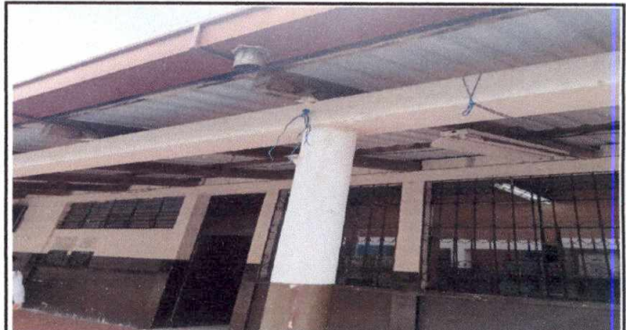
Foto 4: 7.3 INSTALACION DE BAJADAS DE AGUA PLUVIAL
