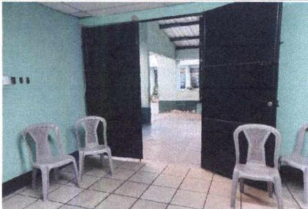
FOTO 3: DESMONTAJE, CORTE Y REINSTALACIÓN DE PUERTAS DE METAL POR INSTALACIÓN DE PISO CERÁMICO EN ÁREA DE SALA DE MAESTROS
