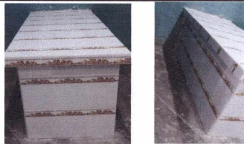
FOTO 6: INSTALACIÓN DE AZULEJO EN DESAYUNADOR DE CONCRETO EXISTENTE
