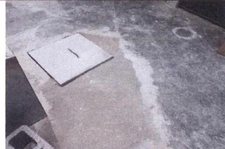
FOTO 4: RELLENO, COMPACTACIÓN, NIVELACIÓN Y FUNDICIÓN DE TORTA DE CONCRETO EN COCINA
