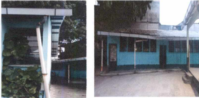
Foto 7: Instalación de bajada de agua pluvial, tubo pvc y codos 4", frente de salones: 7, 8 y 9.
