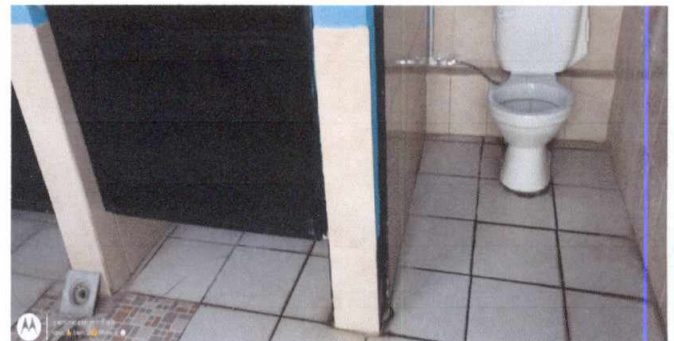
Foto 10: Sustitución de 6 metros lineales de tubería de drenaje, con tubo pvc de 4", incluye desmontaje y reinstalación de 2 inodoros que se encuentran tapados, elaboración de caja de registro 0.80 x 0.40, y sustitución de accesorios a los 2
