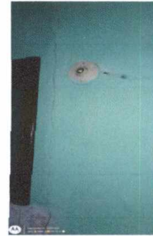
Foto 14: Sustitución de focos tipo led.
