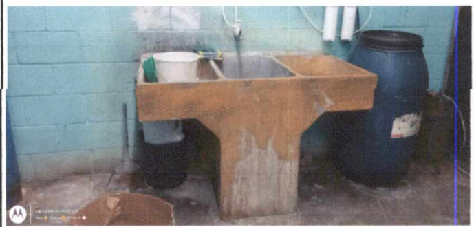
Foto 18: Sustitución de pila de concreto de dos lavaderos e instalación completa. incluye fundición de base de concreto de 2 x 2 mts., conexión a línea de drenaje con tubería pvc e instalación de chorro.
