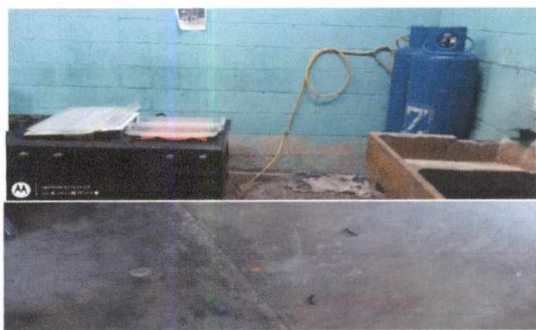
Foto 17: Colocación de piso monos trato en área de cocina.
