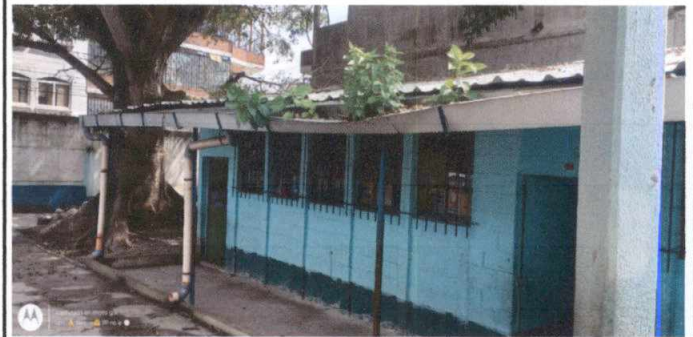
Foto 8: Mantenimiento de techo de lámina, incluye limpieza, limpieza de canales e instalación de 4 pescantes.
