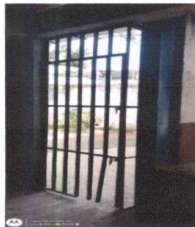
Foto 11: Sustitución de baranda 2.10x0.90 mts. y 2 pasadores con tubo de 2x2 y 2x1.
