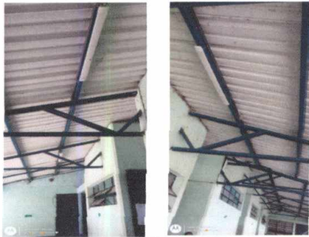
Foto 13: Sustitución de lámparas tipo Led Tecnolite, incluye sustitución de cableado, accesorios e instalación completa. Salones: 1, 2, 7, 8 y 9.
