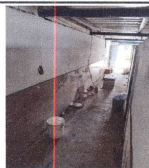
Foto 6: Preparación para colocar piso antideslizante en baño de niñas.
