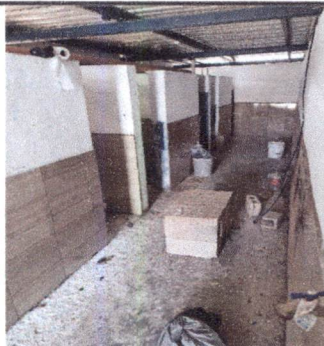
Foto 5: Colocación de piso a un metro de altura en baño de niñas.
