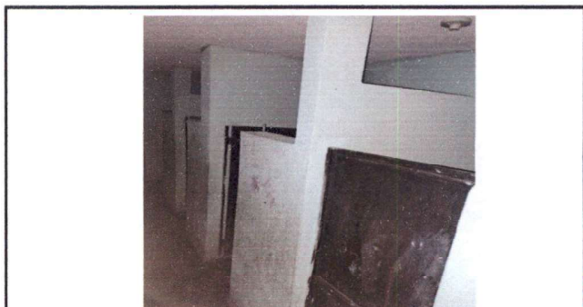
Foto 6: Lijado y pintura de 5 puertas de servicios sanitarios de niñas en el área del anexo.
