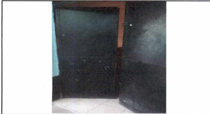
Foto 3: 4.4.1 Mantenimiento a estructura de puertas en aulas, que incluye lijado, cepillado y aplicación de pintura anticorrosiva
