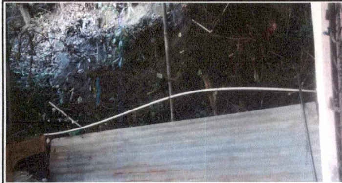
Foto 15: 15.3 Sustitución de malla galvanizada y tubo hg en muro perimetral
