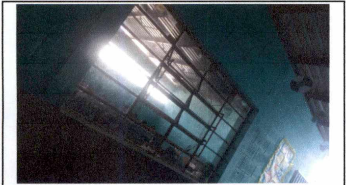
Foto 9: 5.1 Mejoramiento a estructura de metal de ventana que incluye lijado, cepillado y aplicación de pintura anticorrosiva con medidas de 1.12 m de ancho por 1.80 metros de alto en aulas.
