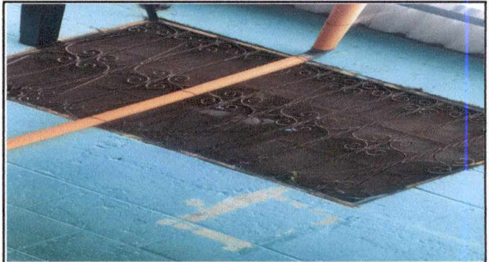
Foto 10: 5.1 Mejoramiento a estructura de metal de ventana que incluye lijado, cepillado y aplicación de pintura anticorrosiva con medidas de 1.60 m de ancho por 1.20 metros de alto en aulas.
