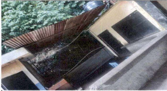
Foto 1: 1.1 SUSTITUCIÓN DE LÁMINA POR LÁMINA TROQUELADA ALUZINC CALIBRE 26 (EN COCINA)
