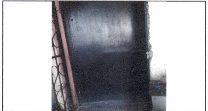
Foto 4: 4.2 SUSTITUCIÓN DE CHAPA EN PUERTA DE COCINA, INCLUYE INSTALACIÓN
