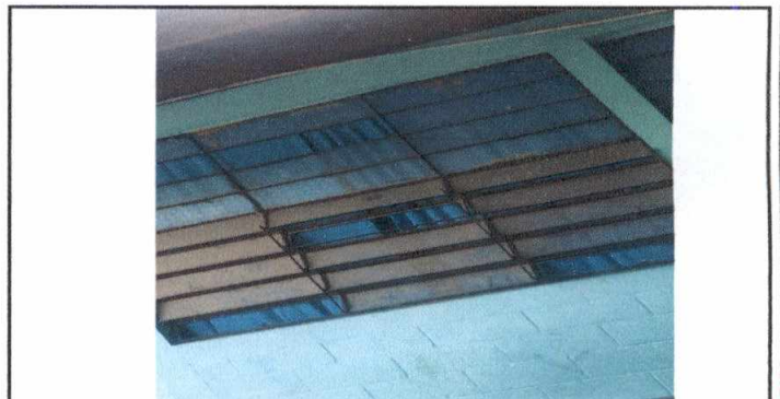
Foto 5: 5.1 Mejoramiento a estructura de metal de ventana que incluye lijado, cepillado y aplicación de pintura anticorrosiva con medias de 1.60 m de ancho por 1.60 metros de alto en aulas.
