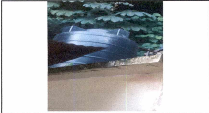
Foto 13: 18.1 Sustitución de depósito de agua 1000 litros a 2500 litros, incluye instalación
