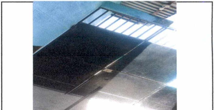
Foto 12: 12.1 Mantenimiento a porton de metal que incluye lijado, cepillado, aplicación de pintura anticorrosiva y mantenimiento de chapa.
