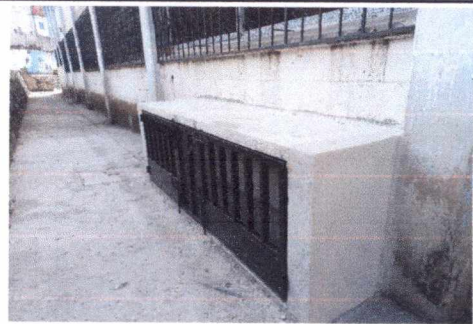
FOTO 4: ÁREA DE ALMACENAMIENTO PARA CILINDROS DE GAS, DE CONCRETO
