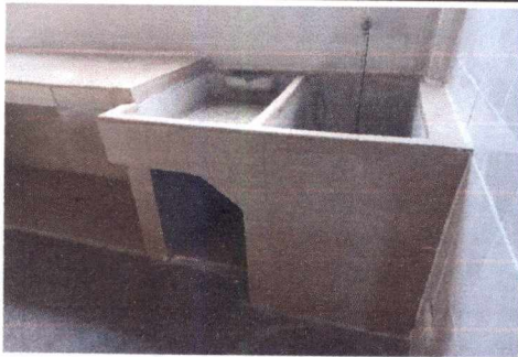
FOTO 9: SUSTITUCIÓN DE PILA POR PILA DE CONCRETO DE UN LAVADERO
