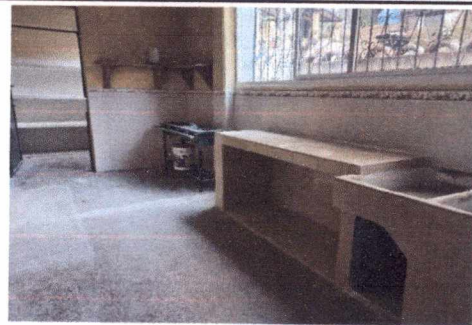
FOTO 10: INSTALACIÓN DE AZULEJO EN COCINA
