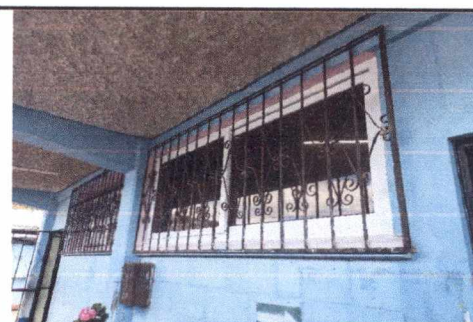
FOTO 6: SUSTITUCIÓN DE VENTANA POR VENTANA DE PVC EN DIRECCIÓN
