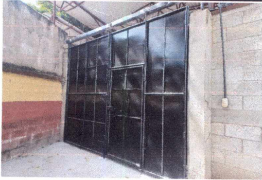
FOTO 7: SUSTITUCIÓN DE PORTÓN DE METAL.
