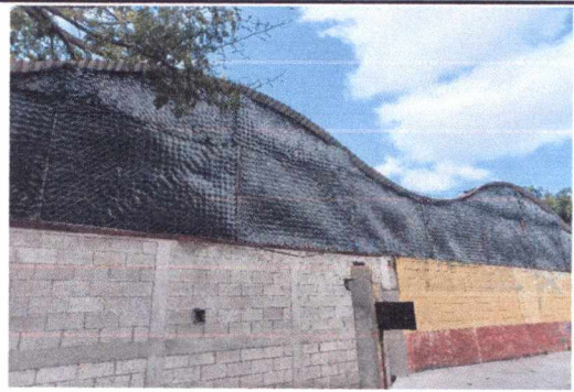
FOTO 2: INSTALACIÓN DE MALLA EN PERÍMETRO FRONTAL DEL ESTABLECIMIENTO
