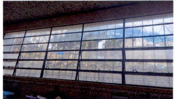
Foto 1: Mejoramiento de ventanería con sustitución de PVC
