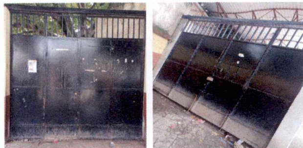
Foto 4: Fabricación e Instalacion de Porton.
