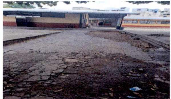
Foto 2: Fundición de 150 m2 desde la entrada principal hasta las gradas.
