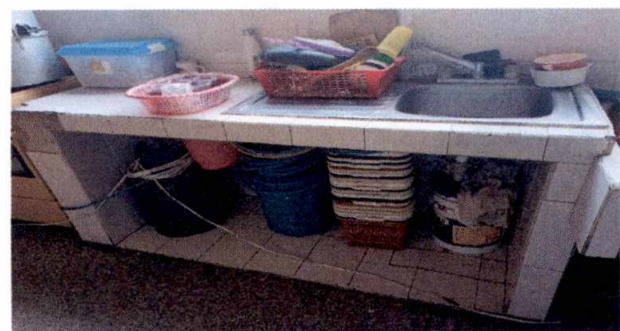
Foto 5: en cocina, mejoramiento de muebles con 3 entrepaños, cambio de azulejo, caseta para cilindros de gas.
