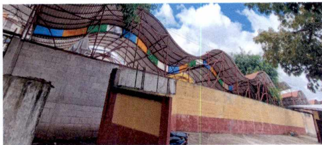
Foto 3: Mejoramiento de perimetro frontal 240 metros2.
