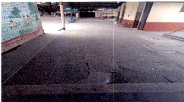
Foto 2: Fundición de 150 m2 desde la entrada principal hasta las gradas.
