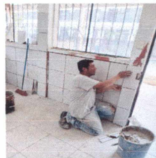
Foto 10: 13. SUSTITUCION DE AZULEJOS/ 13.2 Sustitucion de azulejos de cocina
