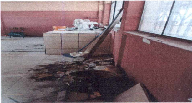
Foto 13: 19. MANO DE OBRA ESPECIALIZADA, ALBAÑILERIA, HERRERIA, ELECTRICIDAD Y PLOMERIA/19.9 Desinstalacion de estructura portante.
