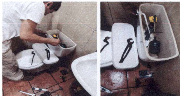
Foto 4: 10. SERVICIOS SANITARIOS Y ACCESORIOS / 10.2 Sustitución de accesorio de inodoro contrallaves, tuvo de abasto tanque
