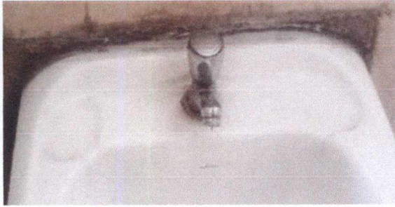
Foto 7:10. SERVICIOS SANITARIOS Y ACCESORIOS / 10.9 Sustitucion de grifos con material.
