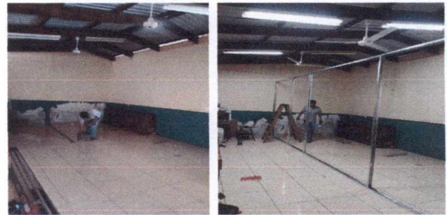
Foto : 18: 19. MANO DE OBRA ESPECIALIZADA EN ( ALBAÑILERIA, ELECTRICIDAD HERRERIA Y PLOMERIA)/ 19.11 Instalacion de unidades de luz (incluyen interruptor, ducto y cable electrico)
