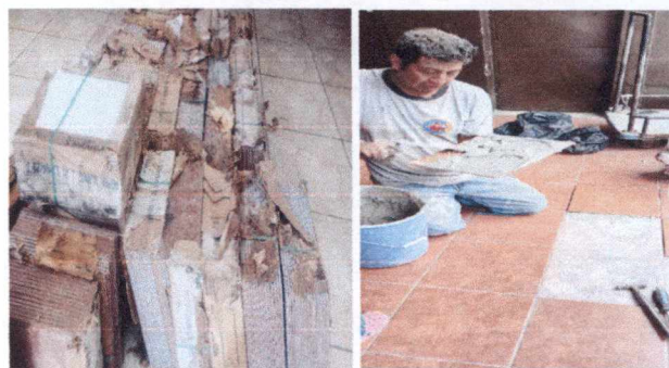
Foto 2: 6. Piso / 6.4 Reparacion de piso ceramico
