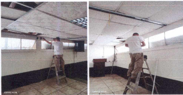
Foto 15: 19. MANO DE OBRA ESPECIALIZADA EN ( ALBAÑILERIA, ELECTRICIDAD HERRERIA Y PLOMERIA)/ 19.11 Instalacion de unidades de luz (Incluyen interruptor, ducto y cable electrico)
