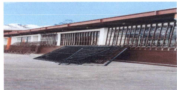
Foto 12: 19. MANO DE OBRA ESPECIALIZADA, ALBAÑILERIA, HERRERIA, ELECTRICIDAD Y PLOMERIA/19.6 Fabricacion e instalacion de puerta de rejas
