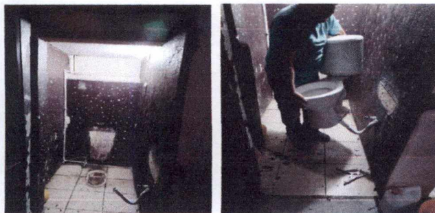
Foto 5: 10. SERVICIOS SANITARIOS Y ACCESORIOS / 10. 3 Sustitucion de dos inodoros
