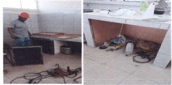
Foto 14: 19. MANO DE OBRA ESPECIALIZADA EN ( ALBAÑILERIA, ELECTRICIDAD HERRERIA Y PLOMERIA)/ 19.3 Fabricacion de puertas de metal en modulos.
