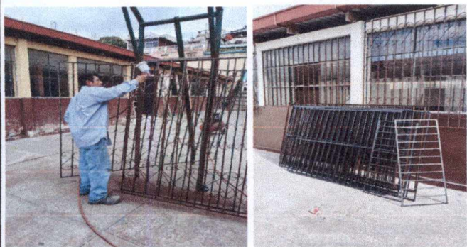
Foto1: 5. Ventanas / 5.1 Mantenimiento de estructura de metal de ventanas
