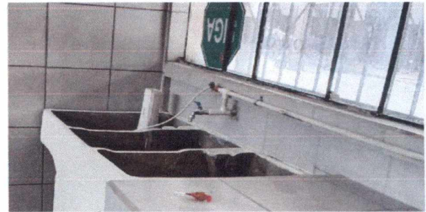
Foto16: 19. MANO DE OBRA ESPECIALIZADA EN ( ALBAÑILERIA, ELECTRICIDAD HERRERIA Y PLOMERIA)/ 19.18 Instalacion de tuberia principal de pvc
