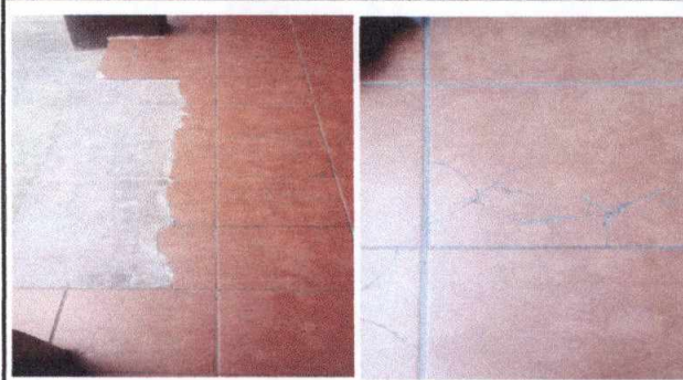
Foto 2: 6. Piso / 6.4 Reparacion de piso ceramico
