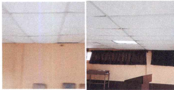
Foto 9: 19. MANO DE OBRA ESPECIALIZADA EN ( ALBAÑILERIA, ELECTRICIDAD HERRERIA Y PLOMERIA)/ 19.11 Instalacion de unidades de luz (incluyen interruptor, ducto y cable electrico)
