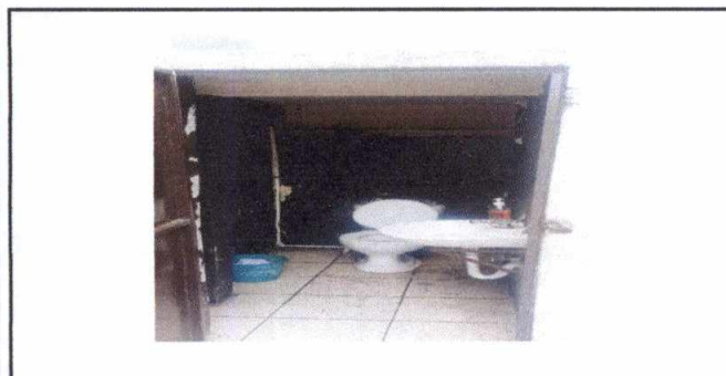
Foto 5: 10. SERVICIOS SANITARIOS Y ACCESORIOS / 10. 3 Sustitucion de dos inodoros 10. 4 Sustitucion de dos lavamanos, contrallave, tuvo de abasto.
