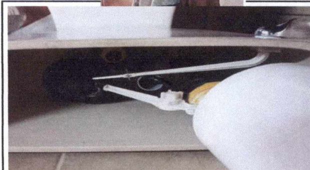
Foto 4: 10. SERVICIOS SANITARIOS Y ACCESORIOS / 10.2 Sustitución de accesorio de inodoro contrallaves, tuvo de abasto tanque
