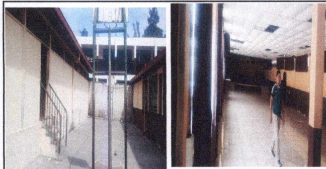
Foto 3: 9. Pintura de muros interiores y exteriores / 9.1 Pintura de muros y exteriores
