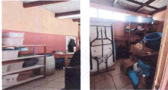
Foto 7: 19. MANO DE OBRA ESPECIALIZADA, ALBAÑILERIA, HERRERIA, ELECTRICIDAD Y PLOMERIA/19.9 Desinstalacion de división de tablayeso.
