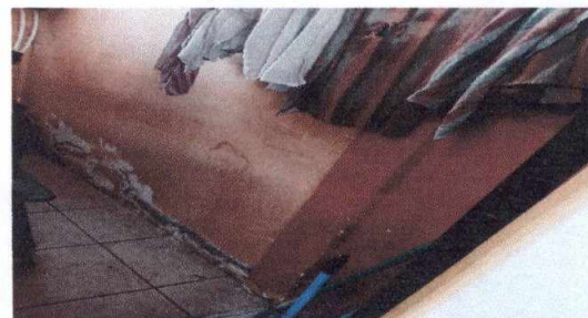
Foto: 20 REPARACION DE COCINA/ Fabricacion de encinera de concreto incluyendo azulejo.
