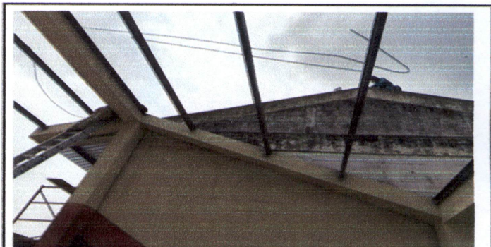
Foto 4: EXTERIOR DE CORREDOR LAMINA ALUZINK CALIBRE 26 TROQUELADA
