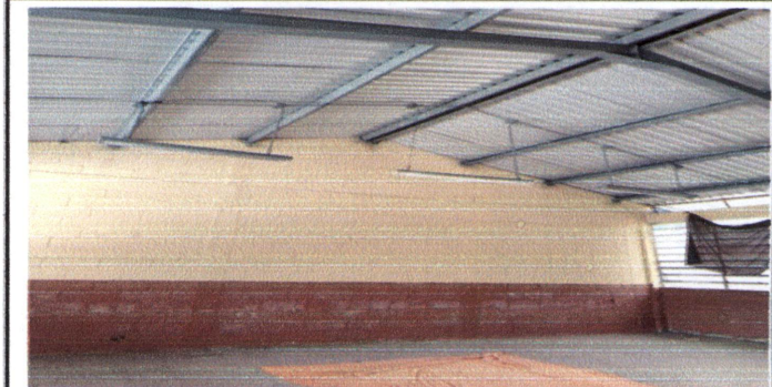
Foto 2: INTERIOR DE SALON 2 LAMINA TROQUELADA ALUZINK CALIBRE 26
