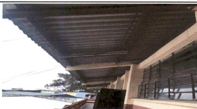
Foto 3: EXTERIOR DE CORREDOR DE LAMINA DE ADVESTO
