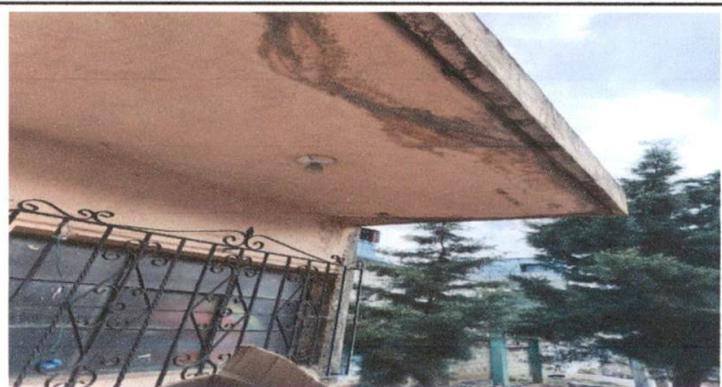
Foto 12: EXTERIOR DE COCINA
