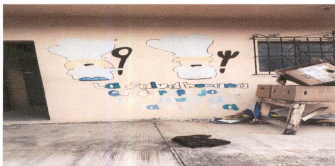
Foto 11: EXTERIOR DE COCINA
