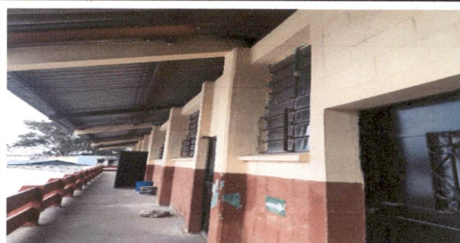
Foto 4: EXTERIOR DE CORREDOR DE LAMINA DE ADVESTO
