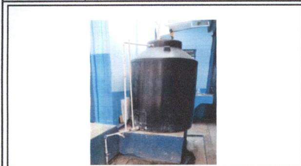
Foto 7: Soporte para depósitos de agua, el cual es ineficiente, por lo que se debe mejorar.
