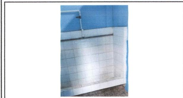
Foto 9: Mingitorio de concreto en mal estado, a sustituir
