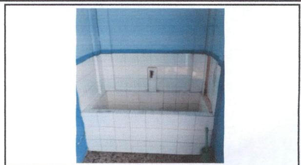
Foto 8: lavamanos de concreto en mal estado, a sustituir
