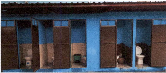
FOTO 9: INSTALACIÓN DE 6 MTS DE PISO CERAMICO ANTIDEZLIZANTE EN MÓDULO DE SANITARIOS.
