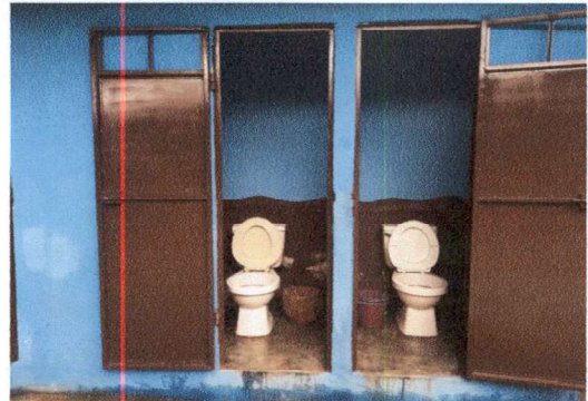
FOTO 10: INSTALACIÓN DE 6 MTS. DE AZULEJO EN 2 SANITARIOS
