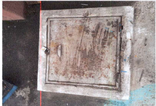
FOTO 8: SUSTITUCIÓN DE TAPADERA DE CISTERNA CON TAPADERA DE METAL ANGULAR DE 1 1/2X3/16 Y LÁMINA DE 3/32 CON REFUERZO EN X.
