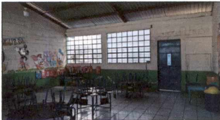
Foto 5: Pintura en muros exteriores e interiores (Pintura Latex)
