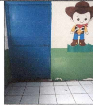
Foto 4: Instalación de Chapa
