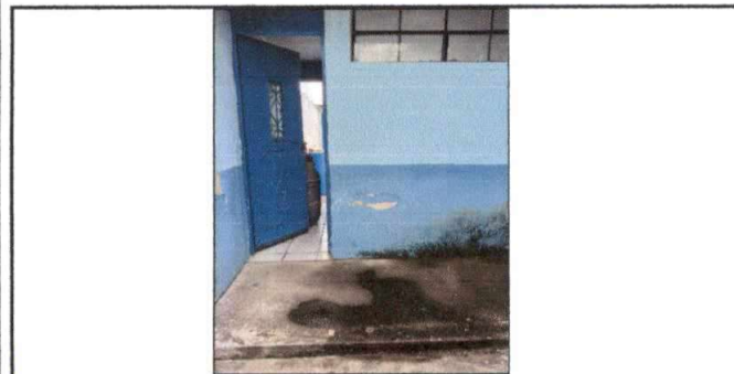
Foto 11: Repello en muro (incluye quitado de repello existente)
