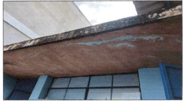
Foto 2: Resanado, raspar y aplicar nuevo alisado en gota de terraza de baños
