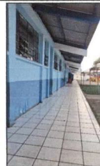
Foto 6: Pintura en muros exteriores e interiores (Pintura Acrílica para Zócalo)
