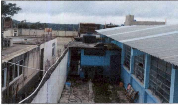
Foto1: Impermeabilización de loza
