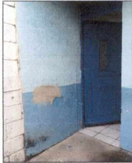
Foto 3: Mantenimiento a Estructura, aplicación de pintura a puertas
