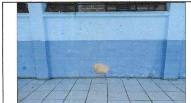
Foto 9: Repello en muro (incluye quitado de repello existente)
