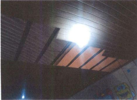
FOTO 1: Sustrucion de duela de cielo falso (Clases)
