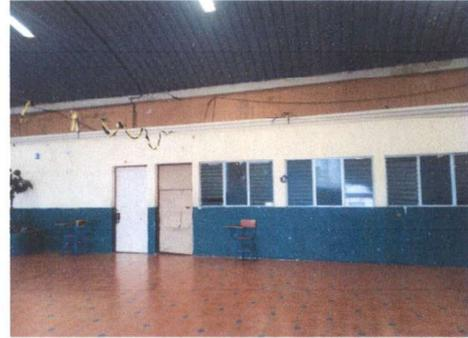
FOTO 2: Sustrucion de ventanas tipo coredizas (clases, 1 metro de altura X 1.50 de ancho)
