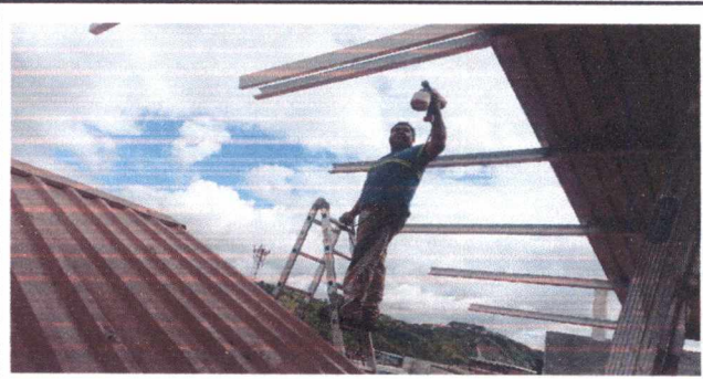
Foto 8: 2.3 Ampliación de estructura de soporte de metal en area del techo para poder evitar filtracion de agua en ingreso principal del Instituto.
