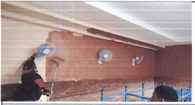
Foto 5: 9.1 Suministro y aplicación de pintura en muros interior de 16 aulas, marca Sur Color para una mejor calidad.
